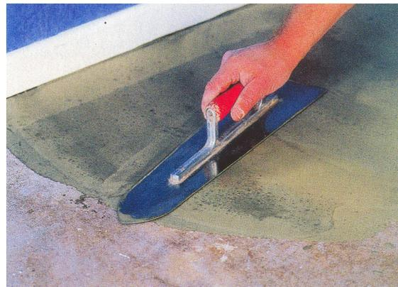
Amasar EDMOR NIVEL SR con un 25% de agua de amasado aproximadamente respecto a la masa del mortero seco. El amasado se realiza con un batidor eléctrico que trabajará a 500 r.p.m. hasta obtener una masa fluida y homogénea. El tiempo de repaso es de unos 2 minutos aproximadamente.
